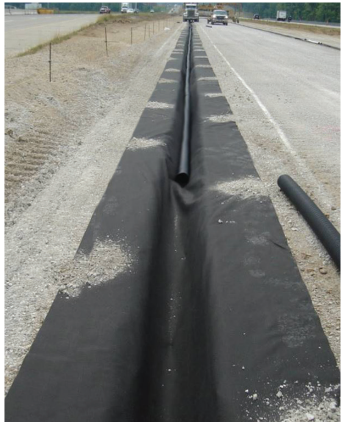
Un géotextile utilisé comme revêtement de tranchée permet à l'eau de passer dans le tuyau, tout en filtrant les fines du sol et en protégeant le tuyau des obstructions.
