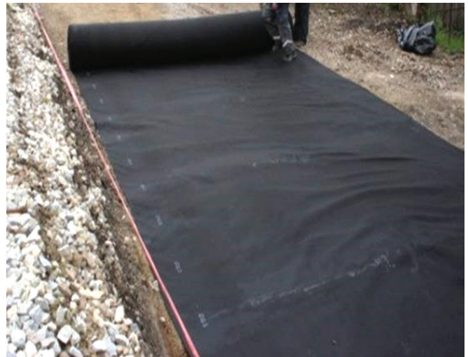
Les robustes non tissés stabilisent les sols de fondation et prolongent la durée de vie de la route.
