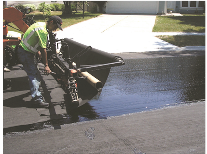
Pour améliorer la durée de vie de la route, utilisez un géotextile non tissé pour séparer le sol et les granulats natifs.
