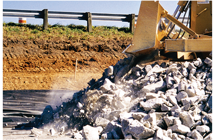
Les géotextiles non tissés ADS agissent comme un filtre pour soulager la pression hydrostatique et empêcher la migration du sol sous les enrochements rigides, comme les enrochements de riprock.
