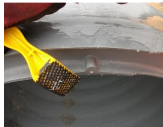
Figure 10: Finition de la soudure
