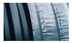
**Étape 3 :** Retirer le film de protection du rabat de fermeture et recouvrir la partie exposée de la sangle, pour ainsi terminer le joint.
