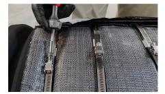
Étape 2 : S'assurer que la sangle centrale se trouve dans la rainure du joint et que les sangles extérieures se trouvent de part et d'autre du joint entre les cannelures. Serrer les sangles avec les outils appropriés, en commençant par la sangle extérieure.
