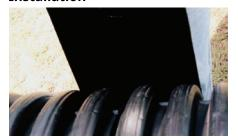
**Étape 1 :** Nettoyer la partie externe du joint pour s'assurer que les matériaux étrangers n'interfèrent pas avec le contact direct entre le mastic de scellement et le joint à sceller.
