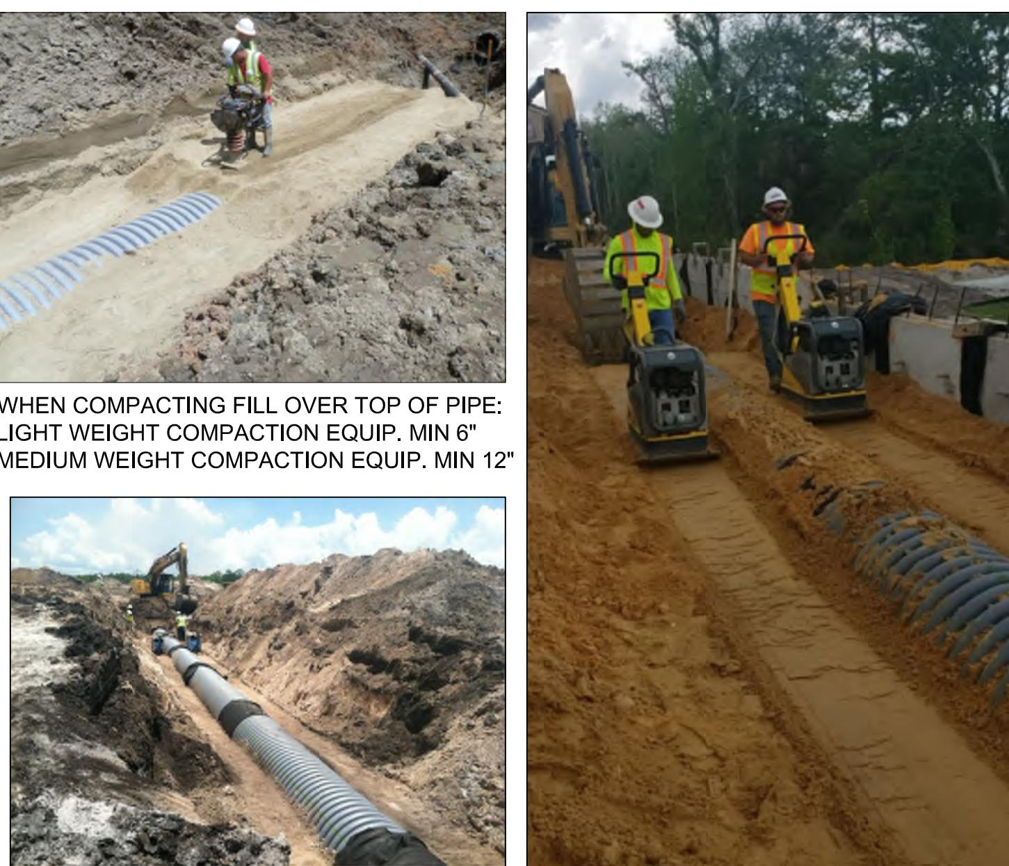
WHEN COMPACTING FILL OVER TOP OF PIPE: LIGHT WEIGHT COMPACTION EQUIP. MIN 6" MEDIUM WEIGHT COMPACTION EQUIP. MIN 12"
