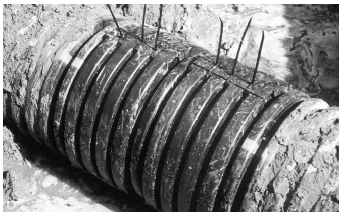
Figure 3 : Installation du manchon fendu
