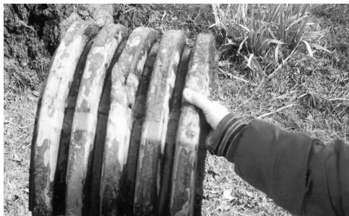
Figure 2 : Emplacement de la coupe du tuyau
