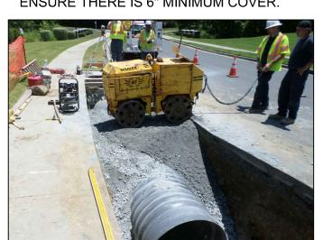
MEDIUM SIZED COMPACTORS MUST HAVE 12" MINIMUM COVER BEFORE COMPACTING OVER THE PIPE.
