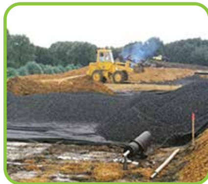
Pour améliorer la durée de vie des routes, envelopper le système de drainage souterrain d'un géotextile non tissé.
