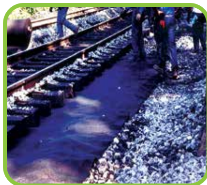
Les géotextiles non tissés robustes stabilisent la fondation et empêchent l'affaissement sous les voies ferrées.
