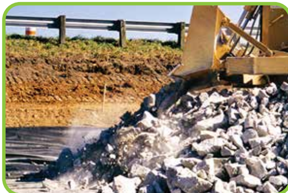
Les géotextiles non tissés d'ADS font office de filtre sous le perré et permettent d'atténuer la pression hydrostatique et de prévenir la migration du sol.
