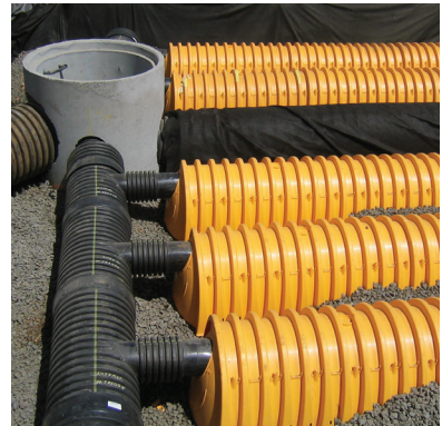
StormTech Isolator® Row Plus
