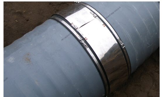
Manchon de réparation
