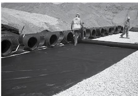
Instale los colectores y coloque geotextil tejido en las filas de entrada [mín. 17.5 pies (5.33 m)] en cada tapón de extremo de entrada. Coloque una pieza continua (sin uniones) a lo largo de la longitud de las filas de Isolator® en dos capas.
