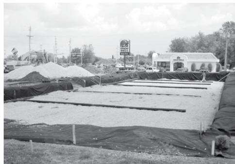
Coloque fundación de piedra angular triturada y limpia, mín. 9" (230 mm) Instale elementos de drenaje si es necesario. Compacte para obtener una superficie plana.
