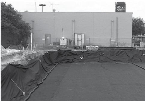
Coloque geotextil no tejido sobre el suelo preparado y en las paredes de la excavación.
