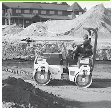
Instale geotextil no tejido sobre la piedra. El geotextil debe traslapar 24" (600 mm) donde se encuentran los bordes. Compacte a 24" (600 mm) del relleno. El rodillo se desplaza de forma paralela a las filas.
