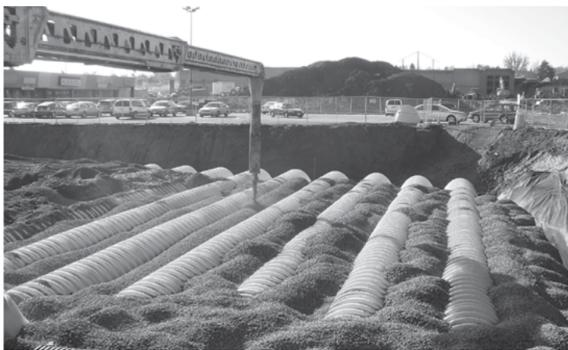
El relleno inicial debe ser ubicado a lo largo de la línea central de la cámara de forma uniforme, anclando la parte baja de la cámara. Esto se logra mediante el uso de un transportador de piedra o una excavadora que alcance a lo largo de la fila.
