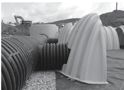
Alinee la primera cámara y el tapón de extremo de cada fila con la tubería de entrada. El contratista puede elegir posponer la colocación de piedra alrededor de las cámaras de extremo y dejar los extremos de las filas abiertos para facilitar la inspección de las cámaras durante el proceso de relleno.
