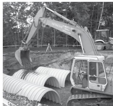
No se debe operar ningún equipo sobre la cama en esta etapa de la instalación. Las excavadoras deben estar alejadas de la cama. Las volquetas no deben descargar la piedra directamente sobre la cama. Las cargadoras no deben estar sobre la cama en este momento.
