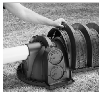
3. Placez la première chambre sur l'obturateur d'extrémité.
