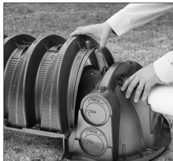
3. Placez la première chambre sur l'obturateur d'extrémité.
