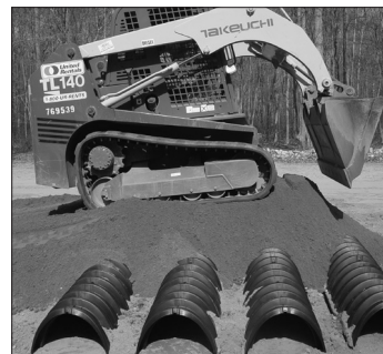
3. Pousser le sable de entre et sur les rangées de chambres.
