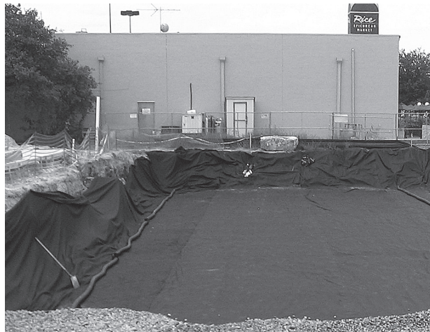
Coloque geotextil no tejido sobre el suelo preparado y en las paredes de la excavación. Instale elementos de drenaje si es necesario.
