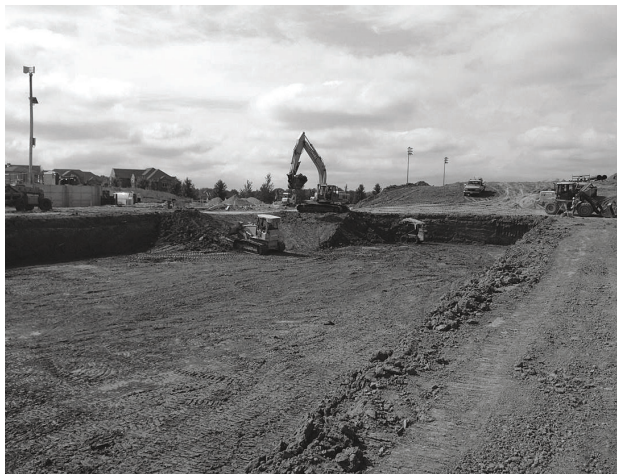
Excave la cama y prepare la subrasante según los planos del ingeniero.
