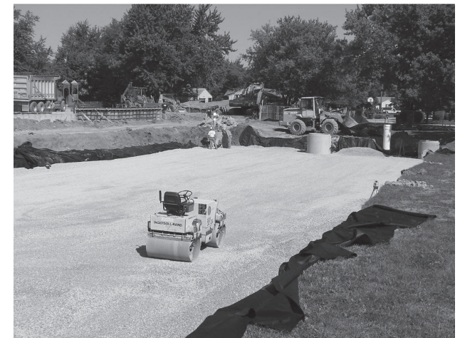
Coloque fundación de piedra angular triturada y limpia, mín. 6” (150 mm). Compacte para obtener una superficie plana.
