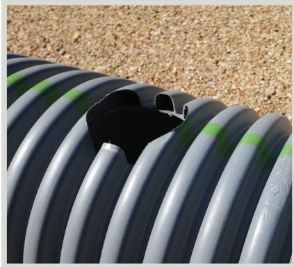
Percer un trou perpendiculaire à la conduite hôte à l'aide de la scie emporte-pièce recommandée. Retirer la découpe de la scie. Ébarber le trou percé.
