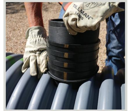
Insérer les manchons en caoutchouc dans le trou percé, les lignes dorées étant perpendiculaires à la conduite. Une fois en place, tirer sur le manchon intérieur tout en poussant sur le manchon extérieur jusqu'à ce qu'il soit fixé sur la conduite hôte.
