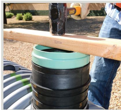
Enfoncer le raccord en plastique dans les manchons en caoutchouc avec un maillet de 4 livres et un bloc de bois. Arrêter lorsque le manchon en caoutchouc arrive à la ligne rouge.
