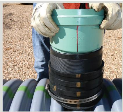
Appliquer une solution savonneuse à l'intérieur du manchon intérieur et sur le raccord en PVC. Insérer à la main le raccord en PVC dans le manchon jusqu'à ce qu'il soit bien ajusté, en alignant la ligne rouge du raccord sur les lignes dorées des manchons en caoutchouc.
