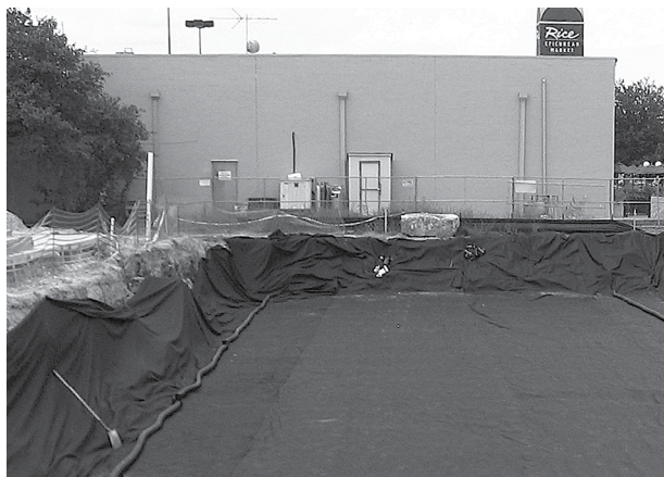
Positionnez le géotextile non tissé sur les sols préparés et sur les parois d'excavation.
