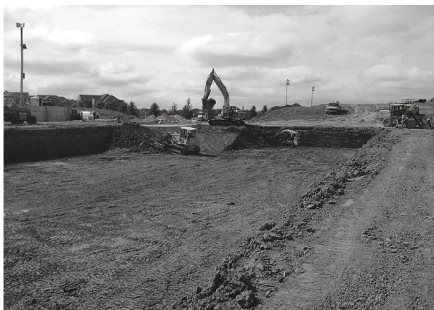
Creusez le lit et préparez le sol de fondation conformément aux plans de l'ingénieur.
