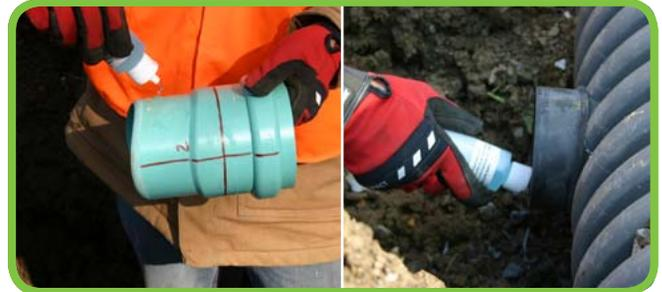
**ÉTAPE 5 :** Insérer l'adaptateur en PVC dans le manchon en caoutchouc. La ligne verticale rouge du tronçon doit être alignée sur la ligne or du manchon. Mettre un bloc de bois sur l'adaptateur et donner des coups de marteau francs sur celui-ci jusqu'à ce que la ligne horizontale rouge du tronçon soit alignée sur le bord du manchon.
