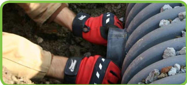
**ÉTAPE 4 :** Appliquer la solution savonneuse sur l'extérieur de l'adaptateur en PVC et à l'intérieur du manchon en caoutchouc.
