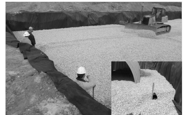
Placez une assise en pierre nette, angulaire et concassée d'une épaisseur minimale de 150 mm (6 po). Compactez pour obtenir une surface plane.
