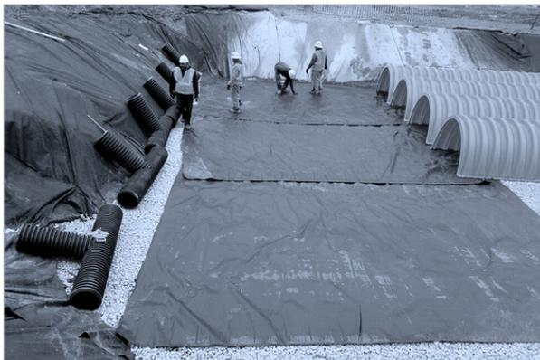
Installez les collecteurs et mettez en place le géotextile ADS Plus à tous les points d'entrée dans les rangées (longueur min 3,8 m (12,5 pi)) et sous chaque bouchon percé. Placez une longueur continue (sans joints, double couche) sur toute la longueur de la Rangée Isolator®.
