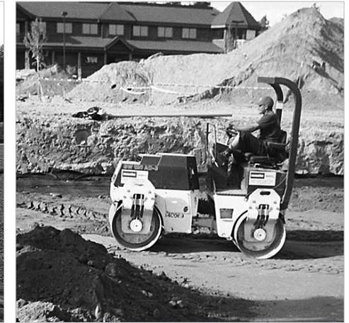
Installez le géotextile non tissé sur la pierre. Le chevauchement du géotextile doit être de 600 mm (24 po) min là où les bordures se rejoignent. Compactez chaque couche de remblai conformément aux spécifications des plans de l'ingénieur de conception du site. Le rouleau compresseur devrait circuler parallèlement aux rangées.
