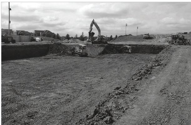
Creusez le lit et préparez le sol de fondation conformément aux plans de l'ingénieur.
