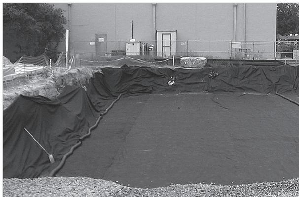
Positionnez le géotextile non tissé sur les sols préparés et sur les parois d'excavation. Installez le drain si nécessaire.
