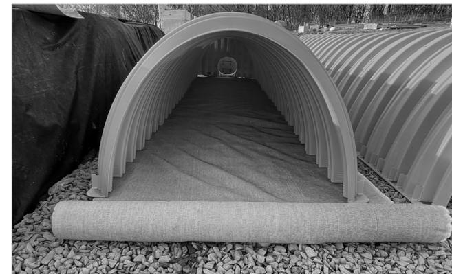
Placez une couche continue de géotextile ADS Plus entre la pierre de fondation et les chambres de la Rangée Isolator Plus, en veillant à ce que le géotextile soit bien à plat et couvre toute la largeur des pieds des chambre.
