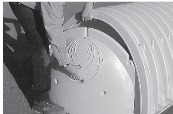
Soulevez l'extrémité de la chambre à quelques centimètres au-dessus du sol. Avec la face concave du bouchon orientée vers l'extérieur, positionnez le bouchon sous la dernière crête de la chambre.
