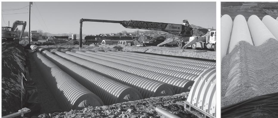
La mise en place de l'enrobage initial doit être fait à partir du centre de la couronne de la chambre pour remblayer de manière uniforme le bas des chambres. Le meilleur moyen d'y parvenir consiste à utiliser un convoyeur de pierres ou une excavatrice le long de la rangée.
