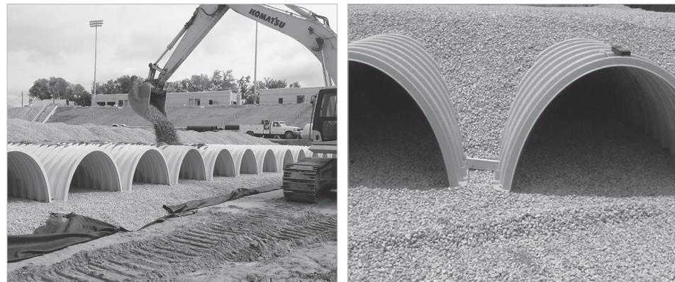
Aucun équipement ne doit être utilisé sur le bassin à ce stade de l'installation. Les excavatrices doivent se trouver hors du bassin. Les camions-bennes ne doivent pas répandre la pierre directement sur le bassin. Les bulldozers ou les chargeuses ne sont pas autorisés à circuler sur le bassin à cette étape.
