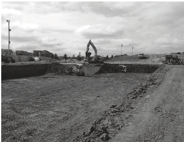
Creusez le lit et préparez le sol de fondation conformément aux plans de l'ingénieur.
