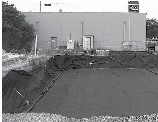
Positionnez le géotextile non tissé sur les sols préparés et sur les parois d'excavation. Installez le drain si nécessaire.
